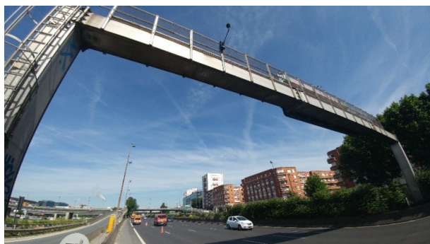
Figure 7: Emplacement d'une station de mesure de surveillance du bruit (A4) à Joinville-le-Pont (94).
