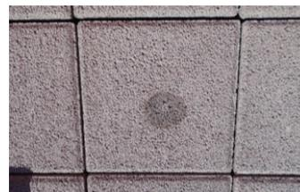
Figure 2 : Pavés en béton de ciment poreux.
