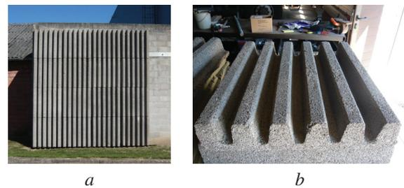
FIGURE 1 – Vue sur l'écran (a) et sur un bloc de béton de bois (b)
