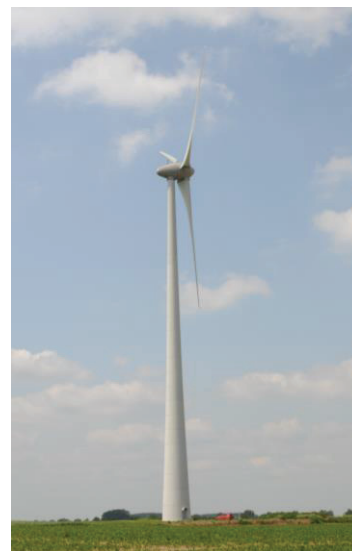
Figure 2 : Eolienne tri pale à axe horizontal de 2 MW
