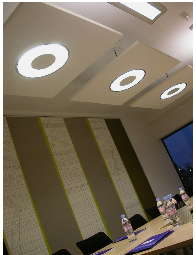
Figure 2 : Panneaux absorbants recevant les luminaires, et laissant 60% de dalle béton nue (BEPOSAC 6ENERGY+)
