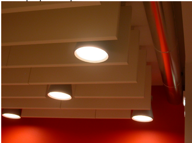
Figure 1 : Baffles absorbants sous dalle béton et traversée de paroi par une gaine (BEPOSAC 6ENERGY+)
