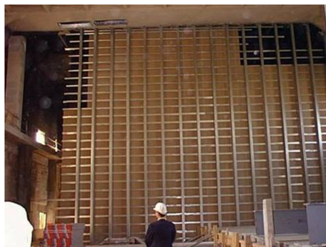
Figure 6 : Studio de la Femis – Paris Cloison séparative de 13m de haut
