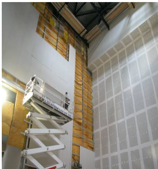
Figure 7 : Studio Belle de mai – Marseille Doublage de 20m de haut
