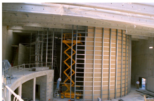
Figure 8 : Cinéma Planétarium – Montpellier Cloison double cintrée 11m de haut / 13m de diamètre
