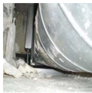
Figure 9 : Vue de l'intérieur du soffit :
